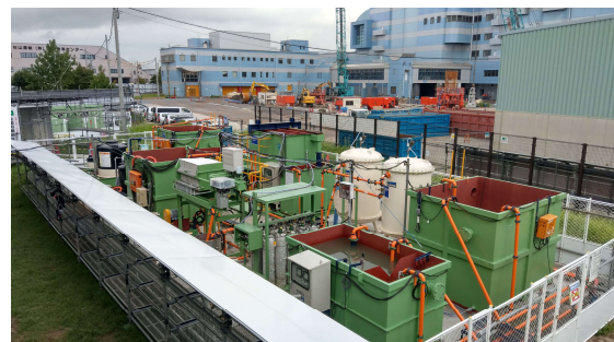
写真④ 排水処理設備設置状況
