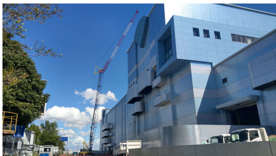
写真③ 工場棟北側施工状況
