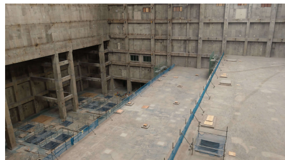
写真② 工場棟炉室施工状況
