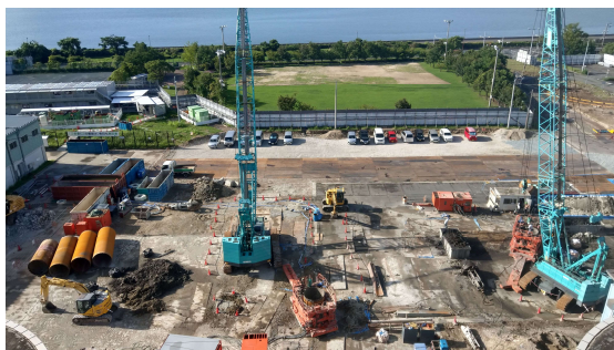
写真① 前処理棟建設状況
