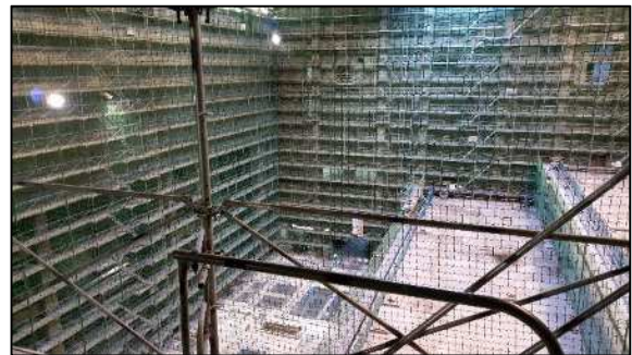
写真② 工場棟炉室施工状況
