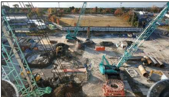
写真① 前処理棟建設状況
