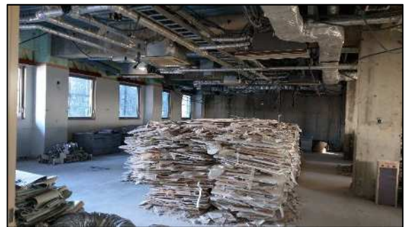
写真④ 管理棟既存設備解体状況
