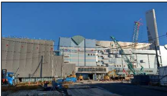
写真③ 管理棟外壁改修状況
