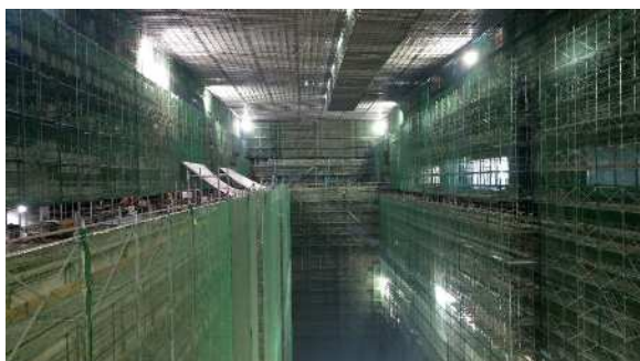
写真③ 工場棟ごみピット補修状況
