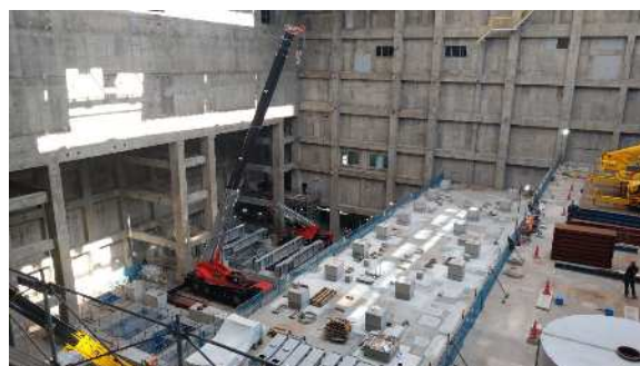
写真② 工場棟炉室施工状況
