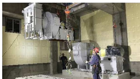
写真④ プラント設備設置状況
