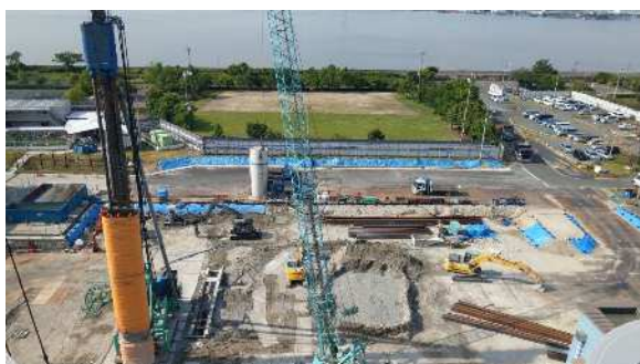
写真① 前処理棟建設状況
