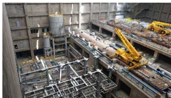
写真② 工場棟炉室施工状況
