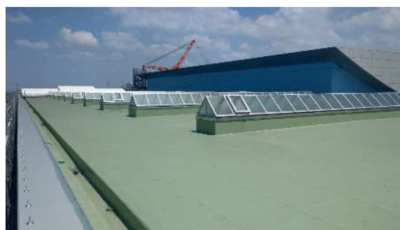
写真④ 屋上防水改修状況
