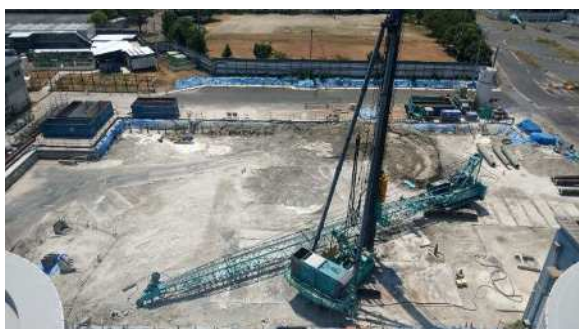
写真① 前処理棟建設状況
