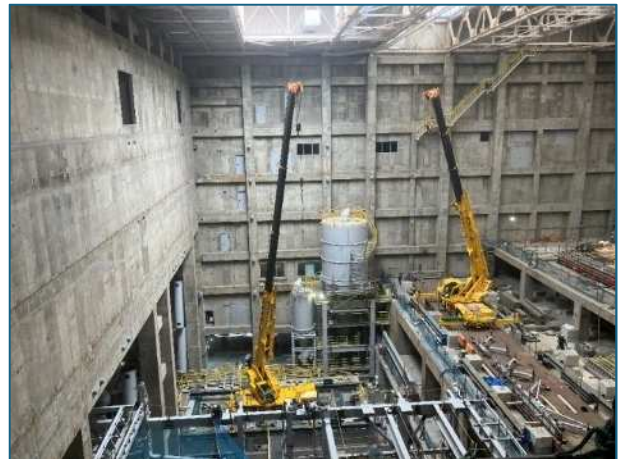
工事状況（焼却施設内部）
