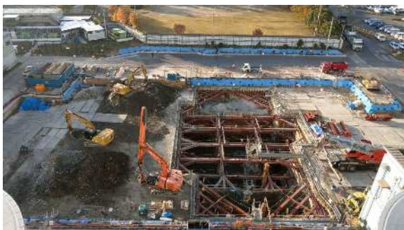
写真① 前処理棟建設状況
