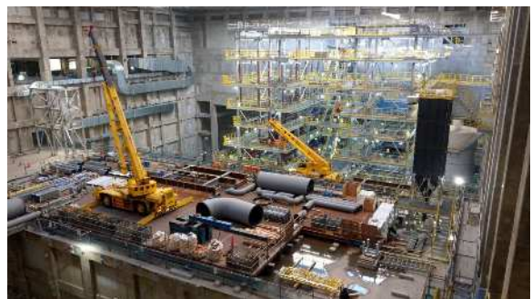
写真② 工場棟炉室施工状況
