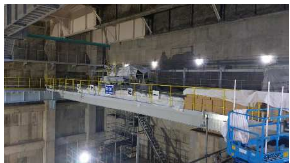
写真④ 灰クレーン設置状況
