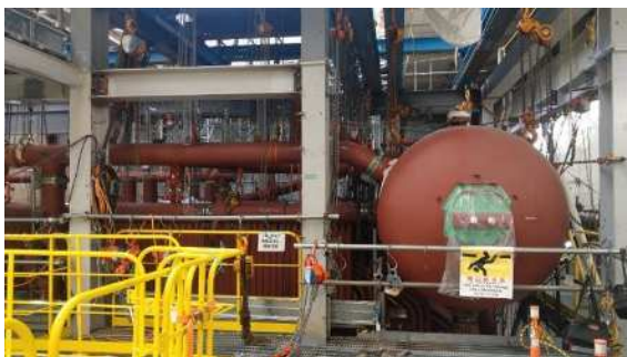
写真③ ボイラドラム設置状況
