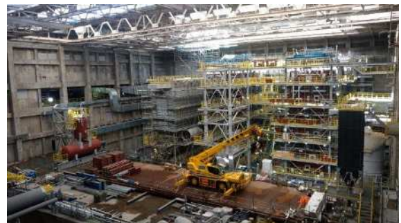
写真② 工場棟炉室施工状況
