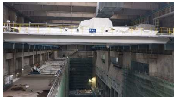
写真④ ごみクレーン設置状況
