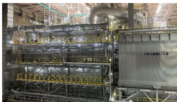
写真③ 工場棟炉室施工状況
