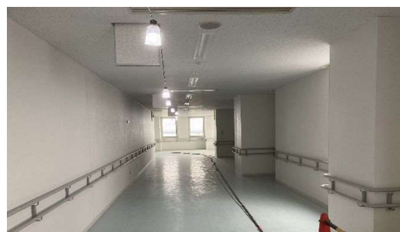
写真④ 工場棟5階見学者通路施工状況
